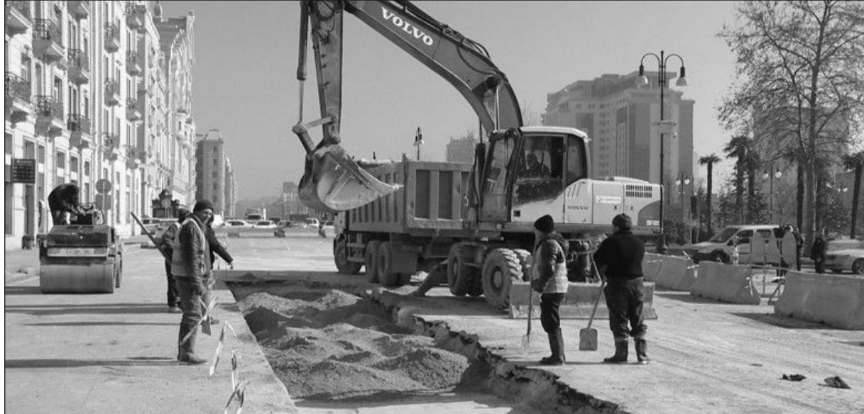
Bakı şəhəri Yasamal rayonunun "Sovetski" kimi tanınan ərazidə çəkilən yeni kanalizasiya xətərinin birləşdirilərək əsas kollektora yönəldilməsinə təmin etmək üçün Füzuli küçəsinin Şixeli Qurbanov küçəsi ilə kəsişməsində qazıntı işlərinə başlanılib.
